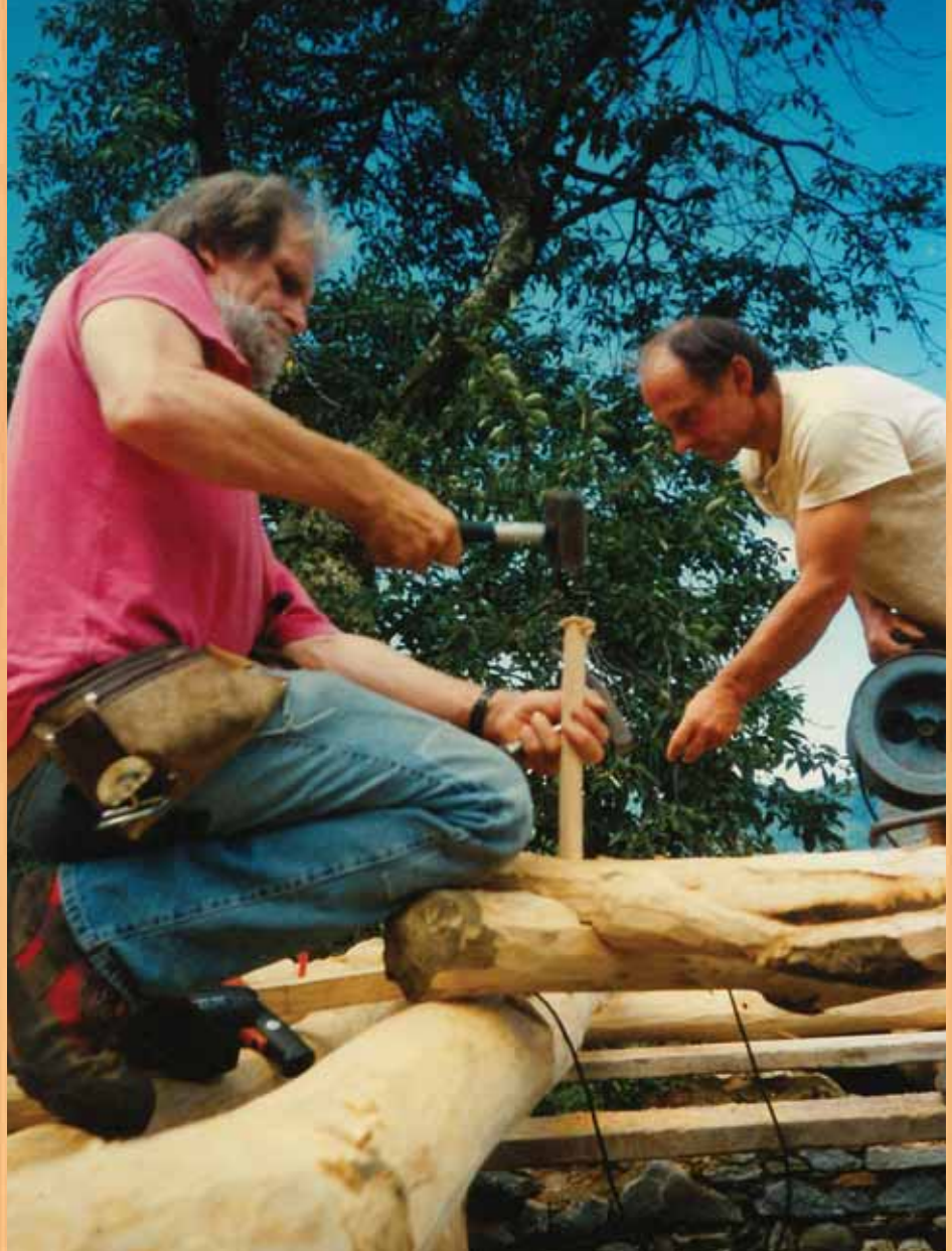
Christian Spiller und Walter Keller fixieren die Grundbalken mit vor Ort angefertigten Kastanienholzstiften
